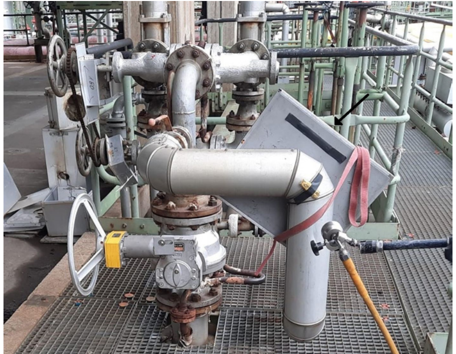
► Bild 10. Aufnahmeanordnung für die digitale Durchstrahlungsprüfung von Rohrleitungen
