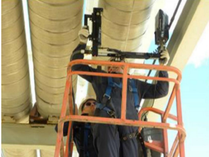
▲ Bild 13. Einrichtung für die Echtzeitradiographie beim Prüfen einer Rohrleitung
